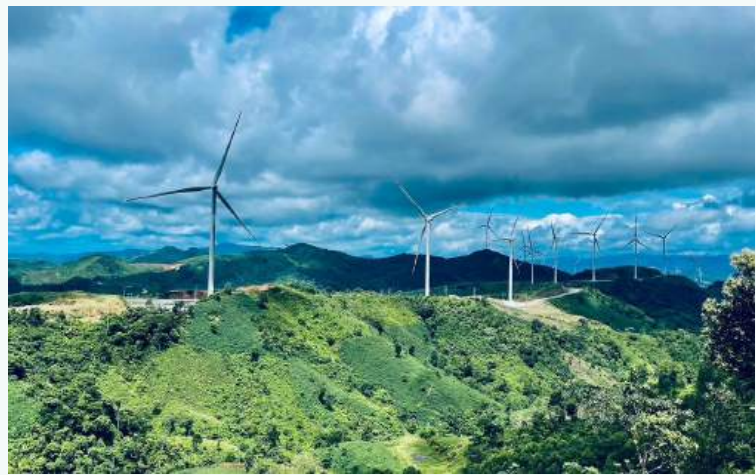
Công trình điện gió ở vùng Tây Quảng Trị - Ảnh: NĐT
