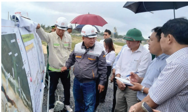
Đoàn công tác Bộ Công Thương khảo sát thực địa tình hình xây dựng Cảng Quốc tế Mỹ Thủy - Ảnh: L.H
