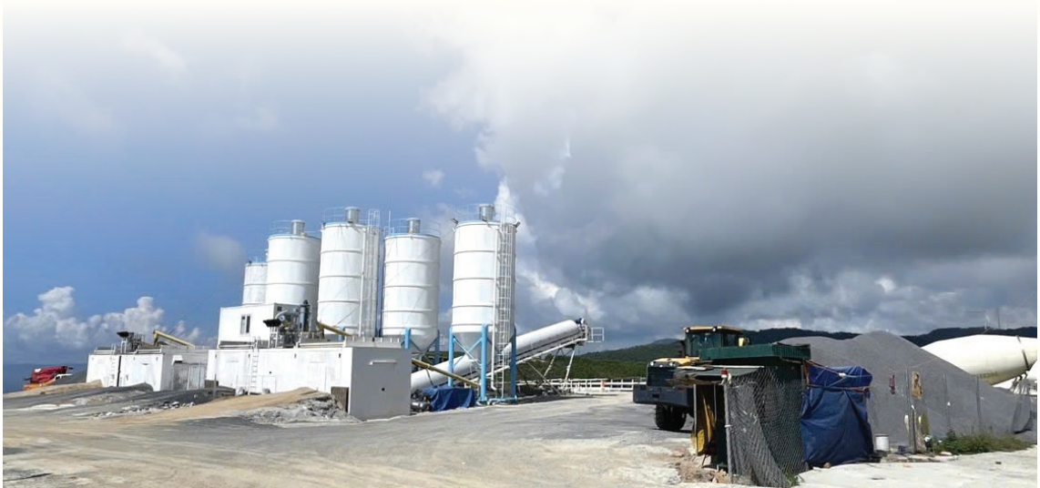
Công trình dự án Nhà máy điện gió Hải Anh tại huyện Hướng Hóa, tỉnh Quảng Trị - Ảnh: L.T.C
