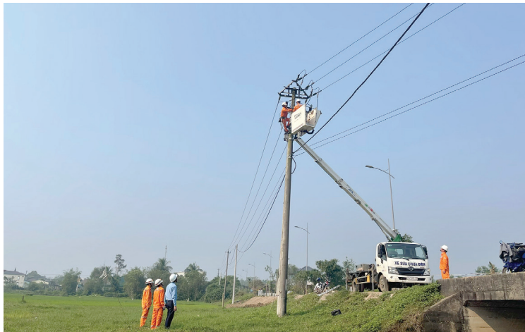
Điện lực Vinh Linh đẩy nhanh tiến độ các công trình có mục đích nâng cao độ tin cậy cung cấp điện - Ảnh: N.Đ
